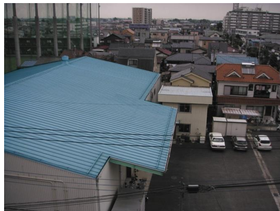
屋根塗装箇所
